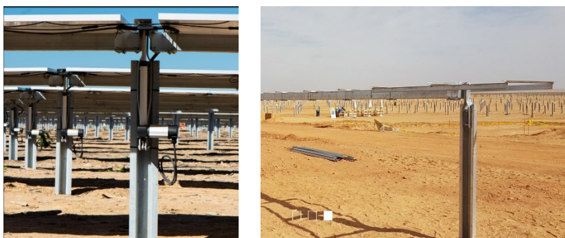
Figura 6 - Particolare strutture ad inseguimento ed attuatore
